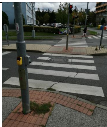
D47 Přechod pro chodce přes východní rameno křiž. Seifertova a Čechovská
