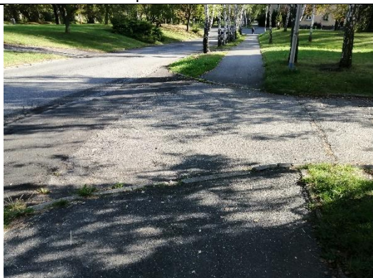
B25 Sjezd k objektu Mariánská č. p. 438
