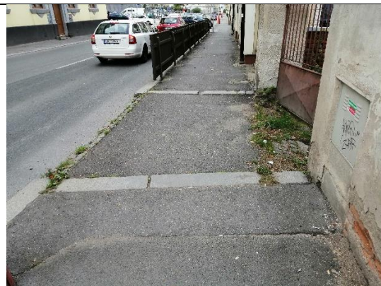
C16 Sjezd do dvora u budovy Čs. armády 145
