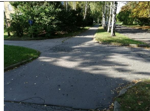
B34 Sjezd do vnitrobloku u objektu Komenského č. p. 415
