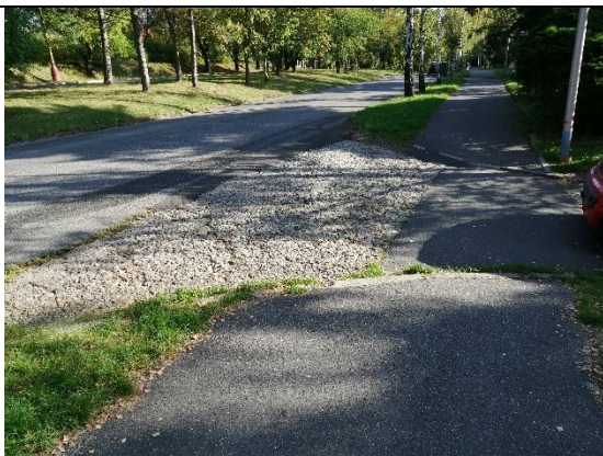
B23 Sjezd k objektu Mariánská č. p. 171
