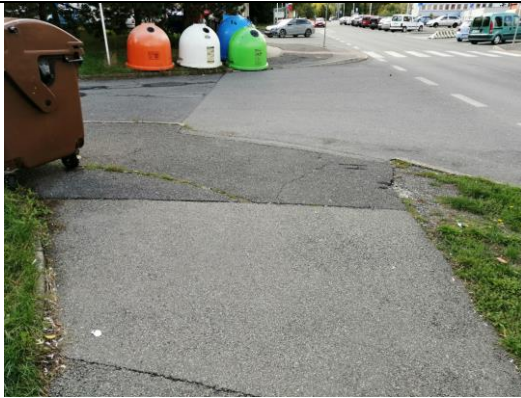
D61 Místo pro převedení chodců přes vozovku k budově Čechovská 61
