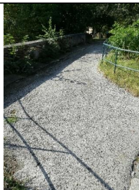
B36 Vyústění chodníku ul. Mariánská u železničního přejezdu
