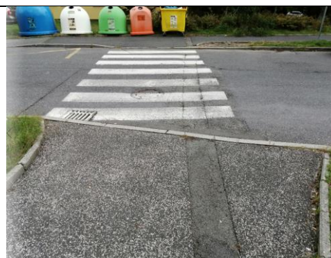
D108 Přejechod pro chodce přes ul. Jana Drdy na úrovni budovy č. p. 494
