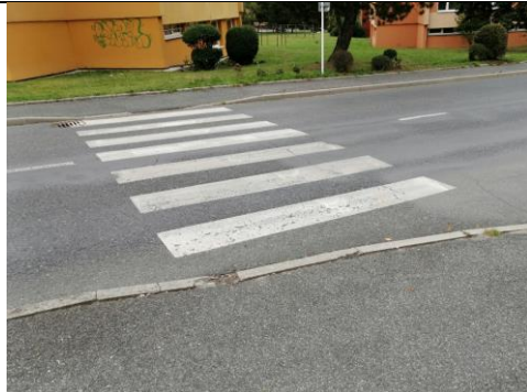
D99 Přechod pro chodce přes ul. Podbrdská jižně od zastávky Drkolnov, Nemocnice
