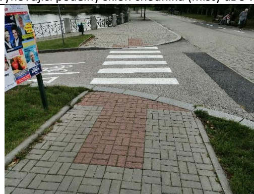
A46 Přechod pro chodce přes stezku pro chodce a cyklisty, poblíž hráze rybníka, Dvořákovo nábř.
