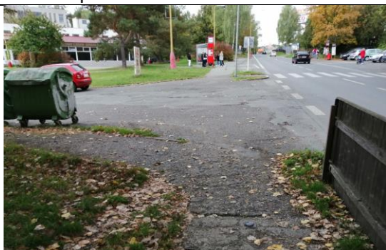
D81 Místo pro převedení chodců přes křiž. ulic Šikmá a Pod Čertovým pahorkem u křiž. s ul. Žežická
