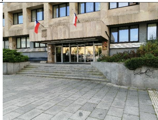
B70 Vstup do budovy Úřadu práce a odloučeného pracoviště ÚZSVM
