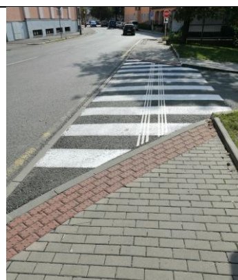
A4 Přechod pro chodce v místě sjezdu ke vchodu do budovy C Oblastní nemocnice Příbram
