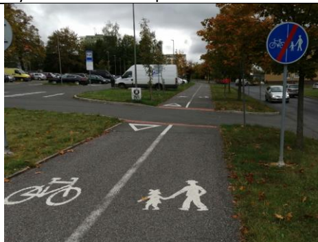
D101 Křižování stezky pro chodce a cyklisty a vjezd na parkoviště P+R Podbrdská
