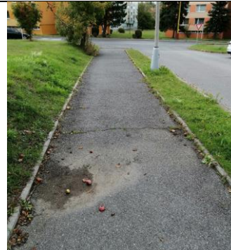
D100 Chodník od hlavního vchodu do areálu II Oblastní nemocnice Příbram k autobusovým zastávkám
