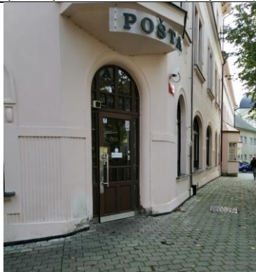
A27 Vstup do budovy České pošty (pošta Příbram 1), ul. Tyršova
