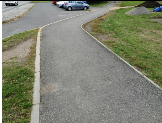
D26 Chodník v ul. E. Beneše od křiž. s ul. Legionářů k budově státního archivu
