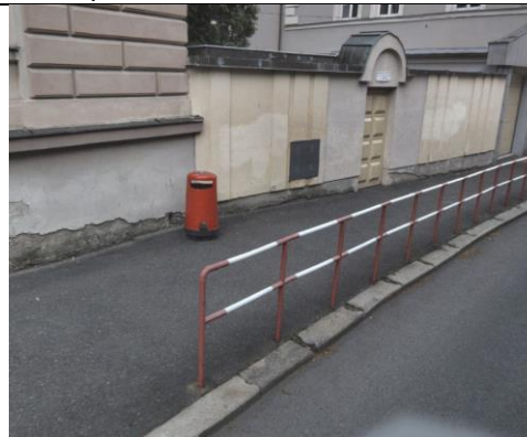
A22 Chodník mezi vedlejším a hlavním vchodem do budovy ISŠ Příbram, ul. Gen. R. Tesaříka
