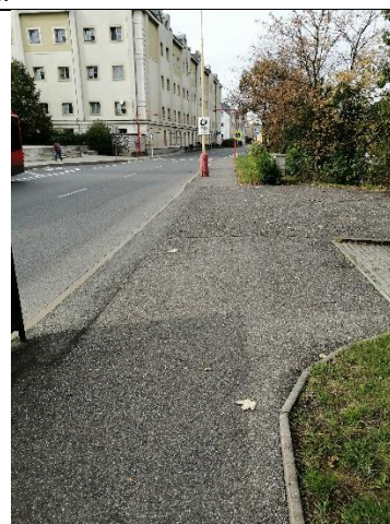
C4 Sjezd k ploše vedle budovy Finančního úřadu
