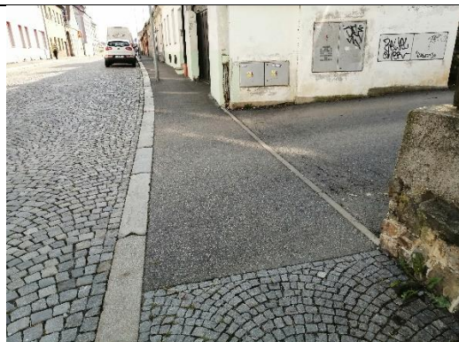
B15 Sjezd na slepou komunikaci k objektu Mariánská č. p. 431
