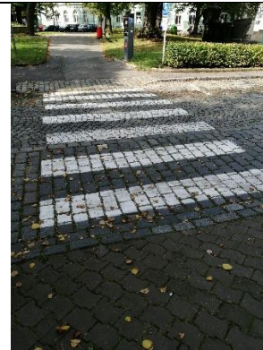
A28 Přečhod pro chodce přes ul. Tyršova, k vyhrazenému park. místu, vstříčně vchodu na poštu
