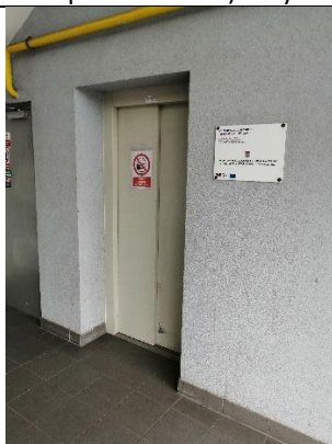
C15 Přístup do odbavovací haly autobusového nádraží
