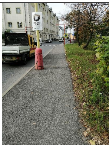
C3 Chodník mezi zastávkou Dolejší Obora a budovou Finančního úřadu
