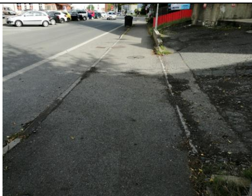
D67 Sjezd k zásobovacím rampám objektu Budovatelů 137
