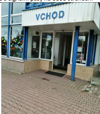
D9 Vchod do budovy aquaparku
