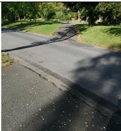
B82 Místo pro překonání ul. Mariánská (rameno z Břez. Hor) směrem do ul. Pod Šachtami
