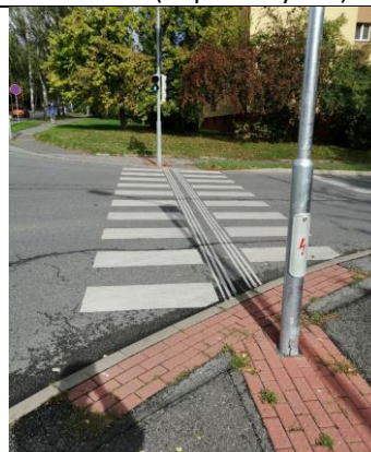
C87 Přechod pro chodce přes východní rameno křižovatky ul. Politických věžňů a Žežická
