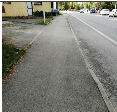
D68 Sjezd k zásobovacím rampám objektů Budovatelů 138 a 139
