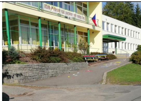
B87 Chodník k hlavnímu vchodu do budovy DDM, ul. Pod Šachtami
