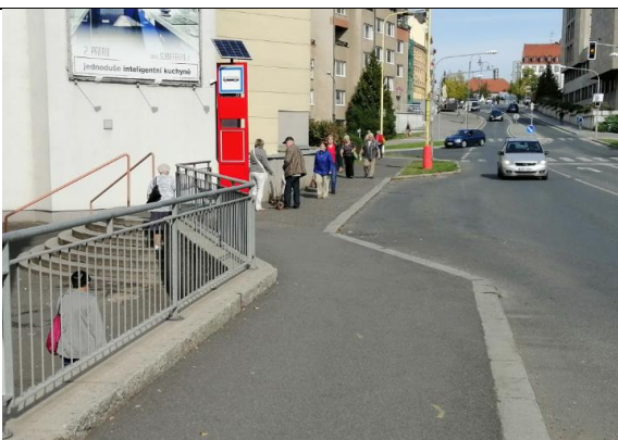
B57 Zastávka Milínská (směr Zdaboř)
