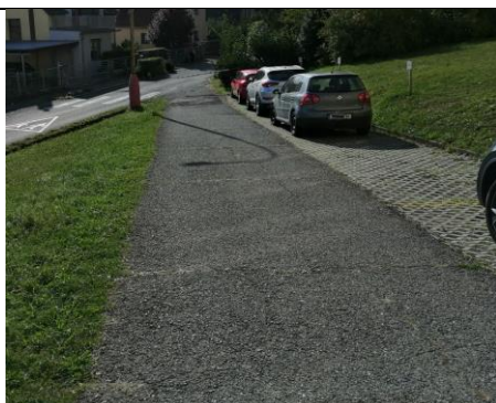
B90 Jižní přístupový chodník k hlavnímu vchodu budovy OU
