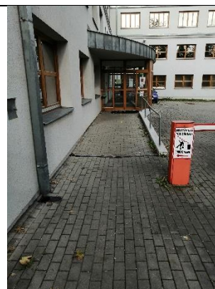
C6 Vchod do budovy Finančního úřadu, ul. Čs. armády 175
