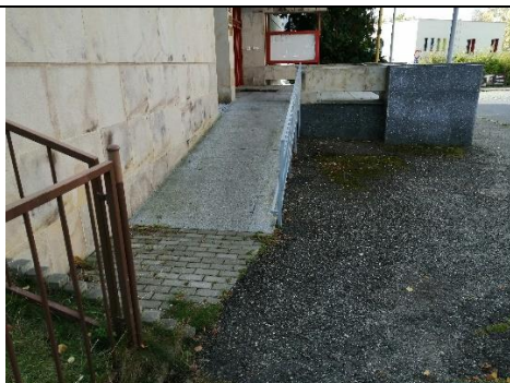
A13 Vchod do budovy Okresního státního zastupitelství v Příbrami, ul. U Nemocnice
