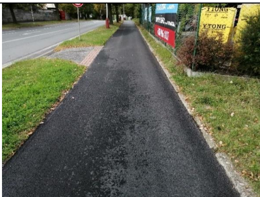
C36 Chodník na třídě Osvobození mezi ul. Březnická a zastávkou Na Cihelně (severní strana)
