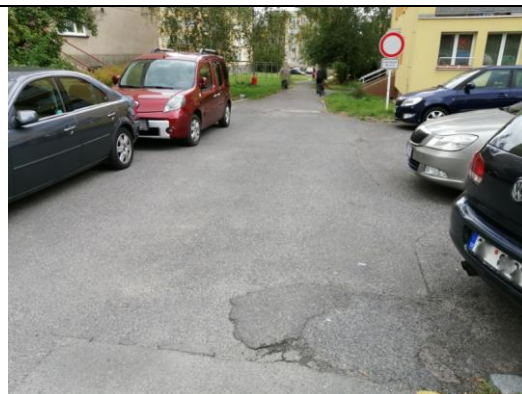
D110 Přístup k budově Domu s pečovatelskou službou, Jana Drdy 494
