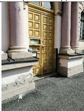
A23 Hlavní vchod do budovy ISŠ Příbram, ul. Gen. R. Tesaříka
