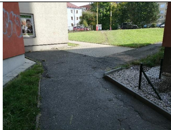
B54 Vyústění chodníku mezi objekty Ryneček č. p. 151 a OC Skalka
