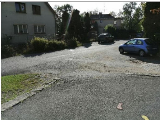
B86 Místo křížení ul. Pod Šachtami a chodníku k budově DDM
