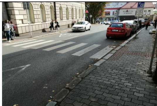
A20 Přechod pro chodce přes ul. Gen. R. Tesaříka před budovou České pošty
