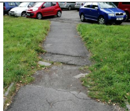
D88 Chodník ze stezky k parkovišti a vstupu u pavilonu D a F do areálu II Oblastní nemocnice Příbram
