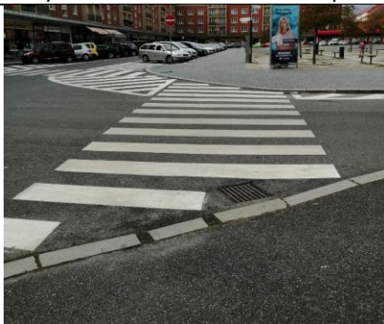
C56 Přechod pro chodce přes severní rameno křiž. tř. Osvobození, K. H. Máchy a náměstí 17. listopadu
