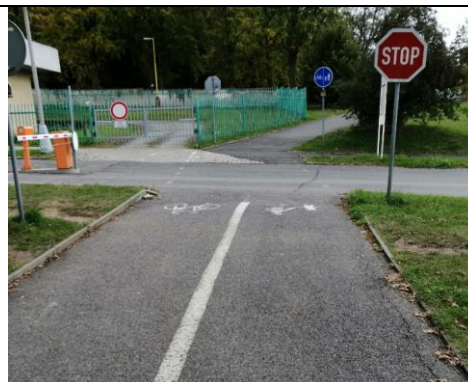
D92 Křížení stezky pro chodce a cyklisty s příjezdovou komunikací ke hlavnímu vjezdu do areálu II Oblastní nemocnice Příbram
