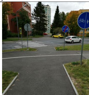
D96 Křížení stezky pro chodce a cyklisty a chodníku od hřbitova k přechodu pro chodce přes ul. Podbrdská
