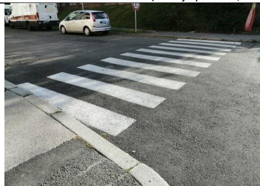
B12 Přechod pro chodce přes ul. Prokopská (před č. p. 9)
