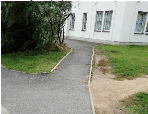
D27 Chodník v ul. E. Beneše k budově státního archivu
