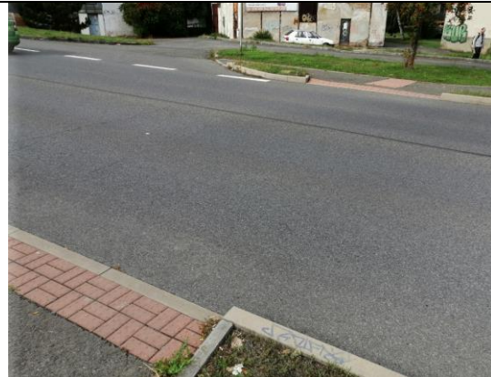
D74 Místo pro přecházení na západní straně parkoviště v ul. K. Kryla BEZBARIÉROVÉ S VÝHRADOU
