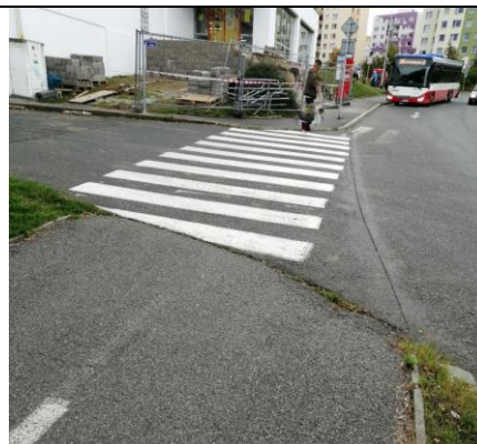
D104 Přejechod pro chodce přes vjezd k zásobovací rampě obch. zař. Billa
