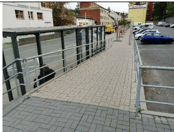
C14 Rampa od budovy autobusového nádraží k zastávce aut. nádr. na ul. Čs. armády
