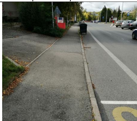
D66 Sjezd k zásobovacím rampám objektu Budovatelů 136
