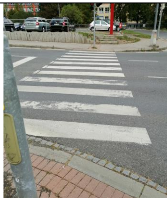
D44 Přechod pro chodce přes západní rameno křiž. Seifertova a Čechovská
