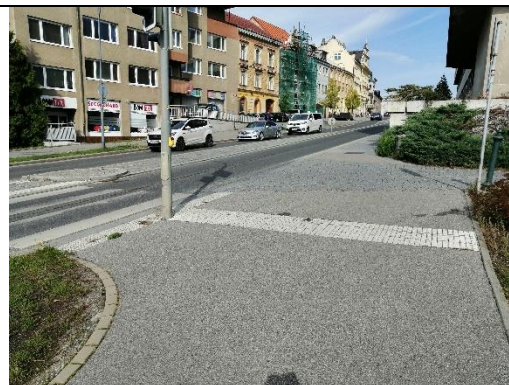
B66 Přechod pro chodce přes ul. Milínská (na straně u úřadu práce)
