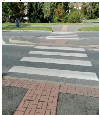
D70 Přechod pro chodce přes západní rameno okružní křiž. Seifertova × S. K. Neumann × Čechovská × K. Kryla
