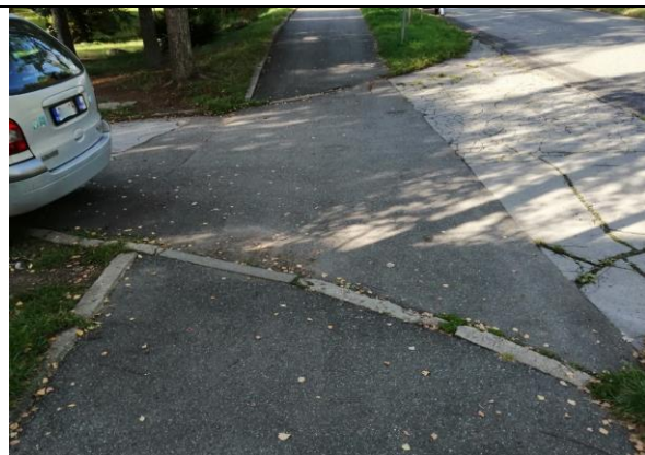
B24 Sjezd k objektu Mariánská č. p. 170
