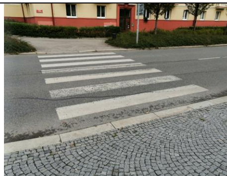
C61 Přejchod pro chodce přes východní rameno křiž. nám. 17. listopadu, ul. Politických vězňů a Obránců míru
