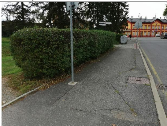
A53 Chodník k železniční stanici (jižní strana vozovky)
