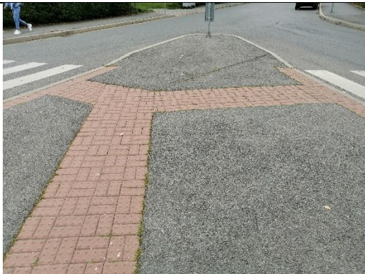
A51 Středový ostrůvek mezi přechody pro chodce v křižovatce ul. Čs. armády a komunikací k nádraží
