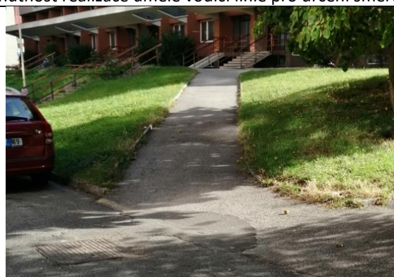
B52 Navazující chodník k objektu Ryneček č. p. 153
