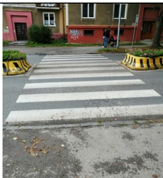
C48 Přechod pro chodce přes třídu Osvobození západně od zastávky sídl.II.poliklinika
