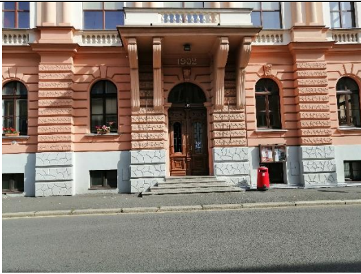
A25 Vstup do budovy sokolovny, ul. Gen. R. Tesaříka
