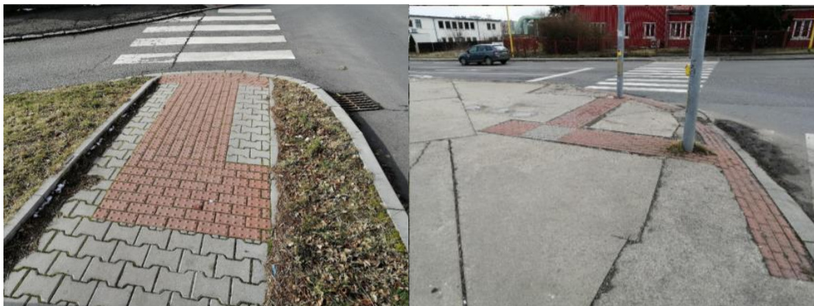
Obrázek 40 Špatné provedení signálních pásů - ul. K Dolu Marie, Husova
