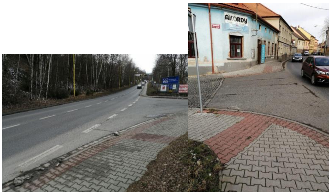
Obrázek 39 Špatné provedení signálních pásů - ul. Husova, Rožmitálská
