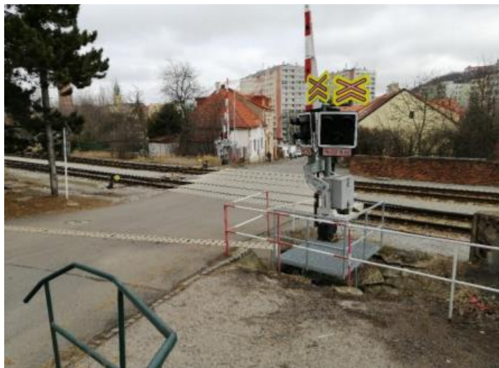
Obrázek 44 Chybějící přechod přes železniční trať v ul. Mariánská
