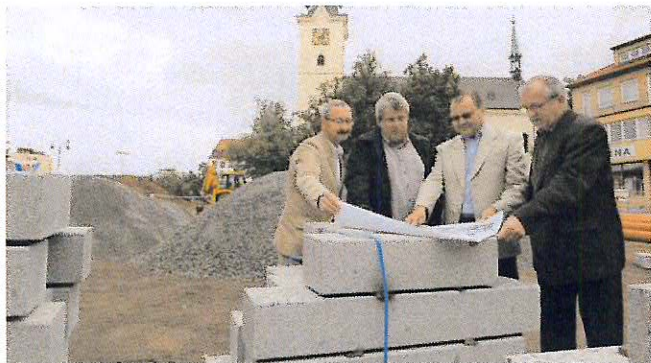
Poslanec Parlamentu ČR Jiří Papež (ODS) navštívil Příbram a prohlédl si staveniště rekonstruovaného náměstí TGM. Zajímal se o budoucí podobu centra staré části Příbrami. Ocenil úsilí vedení příbramské radnice, které se podařilo zkoordinovat postup výstavby i se Středočeským krajem a Ředitelstvím silnic a dálnic ČR. Na snímku si poslanec Papež na rozestavěném náměstí TGM spolu se starostou Příbrami MVDr. Josefem Řihákem a místostarostou MUDr. Ivanem Šedivým a Václavem Černým prohlíží plány rekonstrukce.
