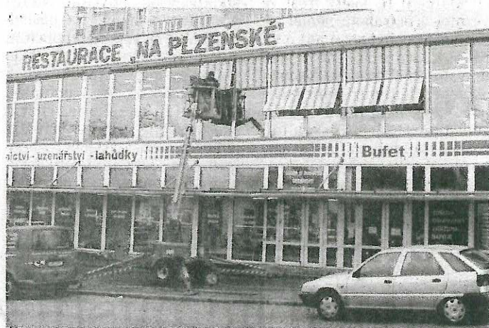
INSTALACE markýz na školní restauraci v Uranu. Foto: Jana Petráňová.
