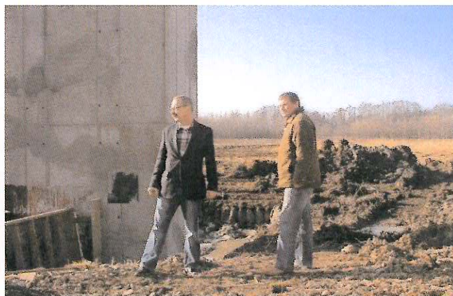
Místostarosta MUDr. Ivan Šedivý se zúčastnil jednání Správní rady Svazku pro vodovody a kanalizace. Konalo se u Vokačovského rybníka, který právě prochází rekonstrukcí.
