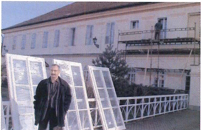
Ředitel Pečovatelské služby Příbram a 1. místostarosta MUDr. Ivan Šedivý kontroluje postup prací při výměně oken na budově Domu s pečovatelskou službou na Březových Horách.
