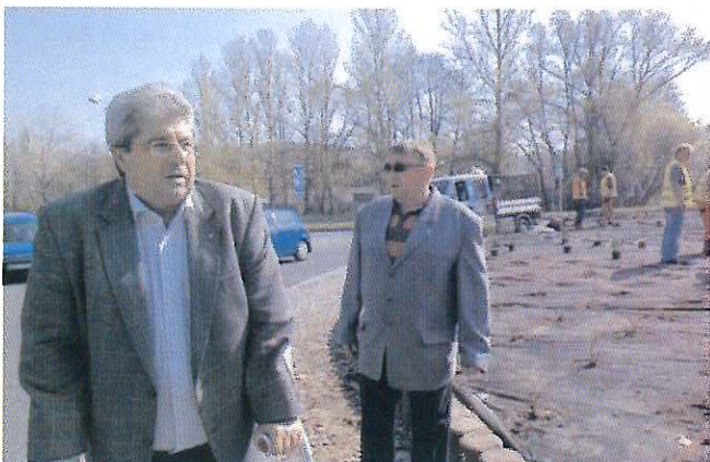
Práce na ozelenění kruhových objezdů v Příbrami jsou v plném proudu. Město na tuto akci získalo dotaci. Starosta MVDr. Josef Řihák pravidelně kontroluje postup prací.
