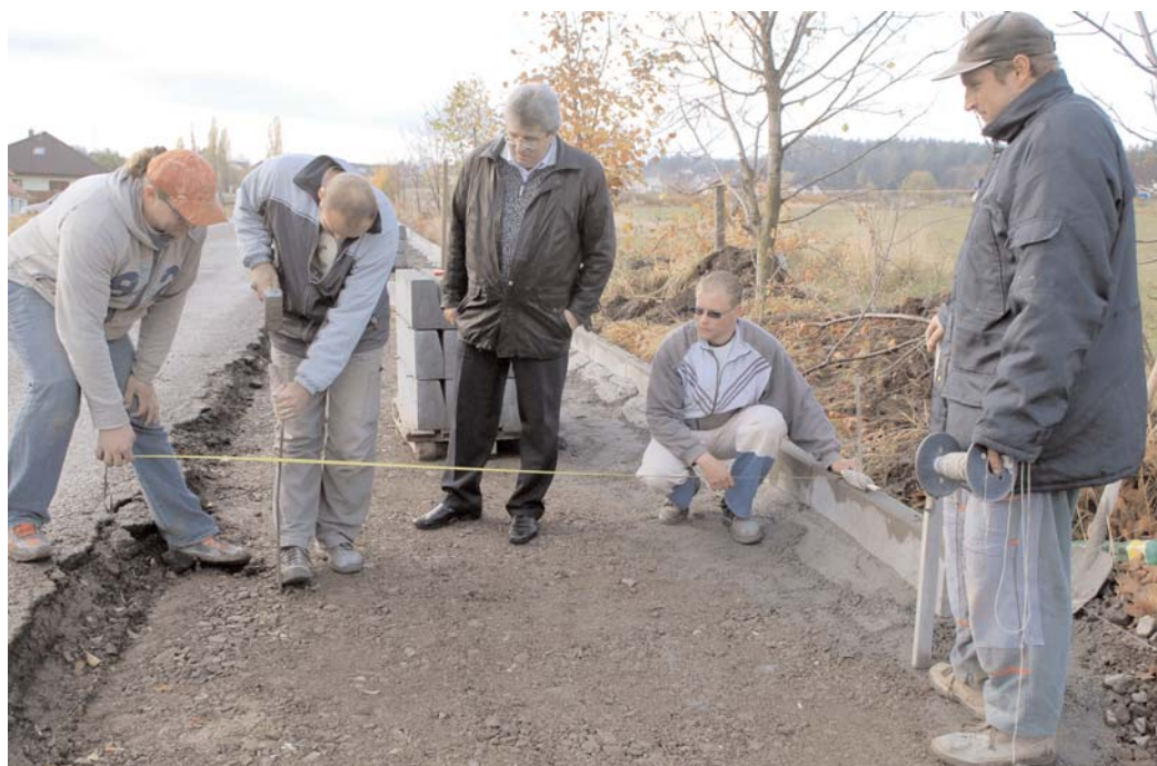
Starosta J. Řihák se zúčastnil kontrolního dne na stavbě chodníku a veřejného osvětlení z Příbrami do Žezic.
