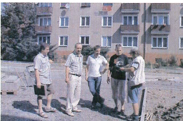
Místostarosta MUDr. Ivan Šedivý při pravidelné kontrole na stavbě v ulici Bratří Čapků.
