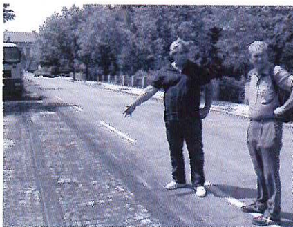
V pondělí 25. května 2009 začala závěrečná etapa výstavby odpovídající a pěší zóny Hořejší Obora. V této souvislosti je pro automobilovou dopravu uzavřeno Dvořákovo nábrží. Stavba bude podle uzavřené smlouvy s dodavatelem dokončena nejspíše do konce července 2009.
