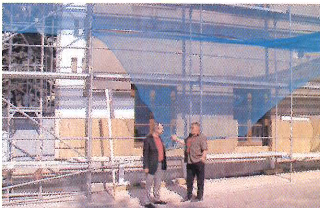
Další rozsáhlou investiční akci, kterou místostarosta MUDr. Ivan Šedivý pravidelně kontroluje, je zateplení budovy Základní školy Březové Hory. Součástí této stavby je i výměna oken.
