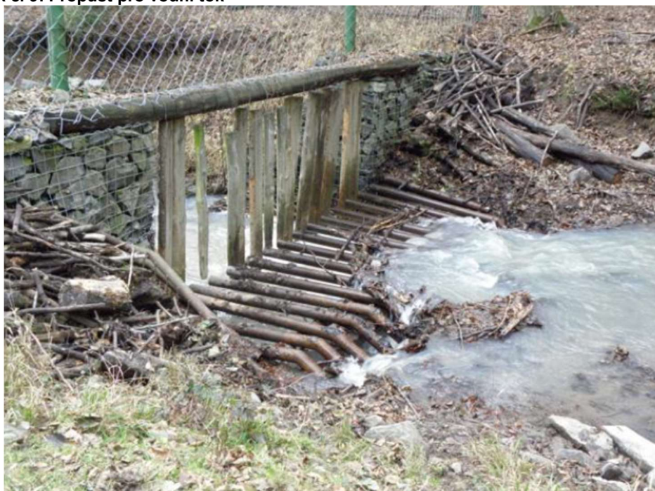
Obrázek č. 9: Propust pro vodní tok
