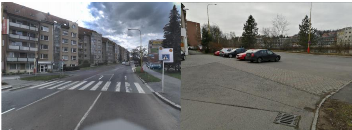
Obrázek 47 Nenormové přechody pro chodce - ul. Milínská, Podskalí
