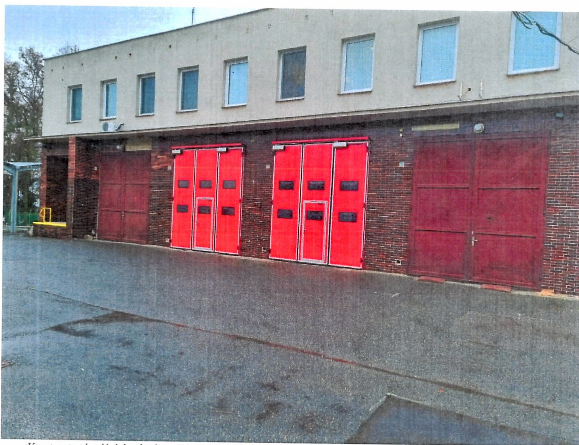
Kontrast stávajících plechových křídlových vrat a nových skládacích vrat s technologickým ovládním
