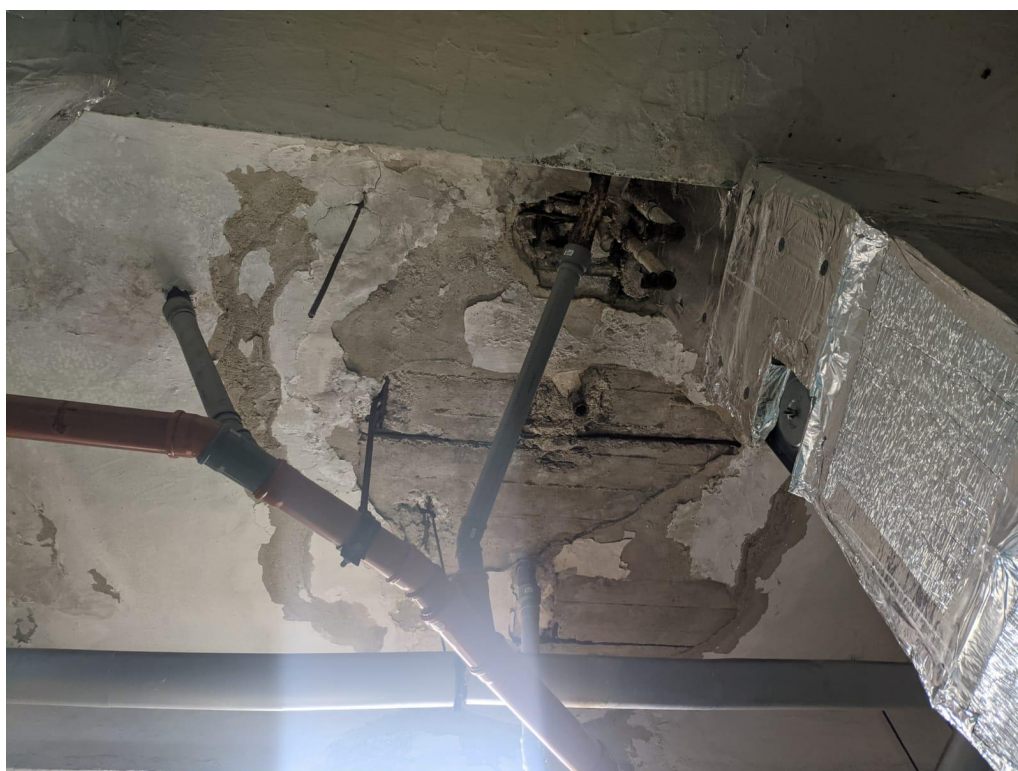
Obrázek 2.7 Nefunkční hydroizolace
