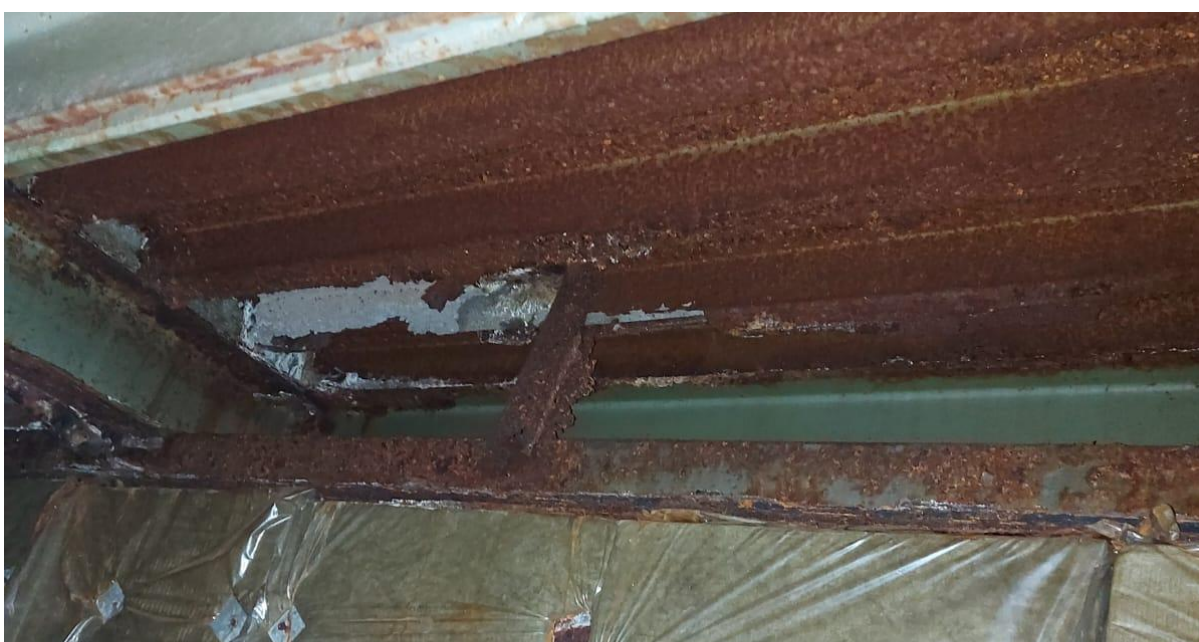
Obrázek č. 2.3 Zatékání střechou
