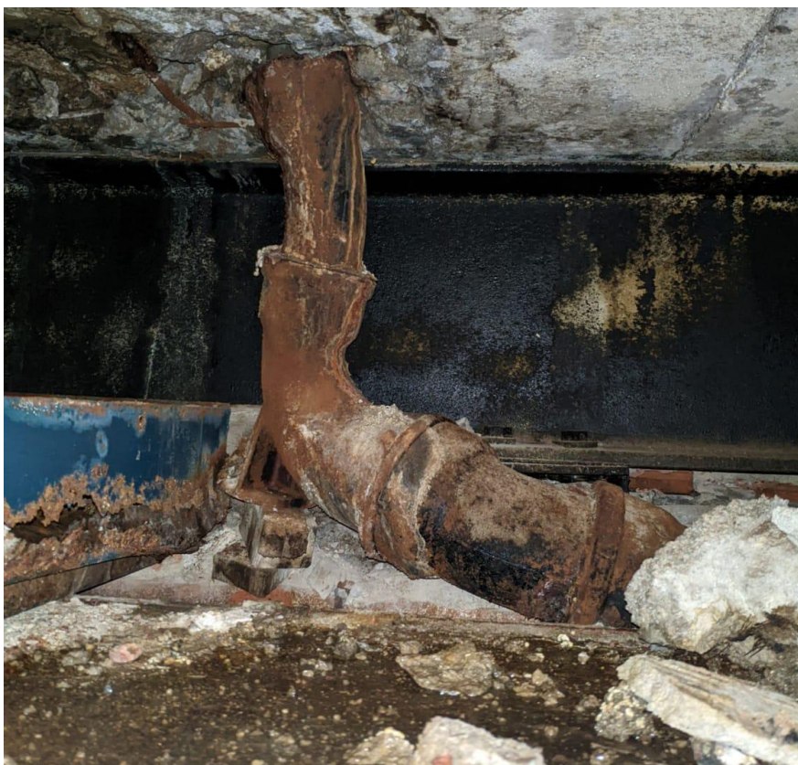
Obrázek č. 2.6 Havarijní stav armatur
