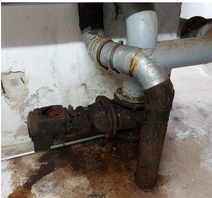
Obrázek č. 2.6 Havarijní stav armatur
