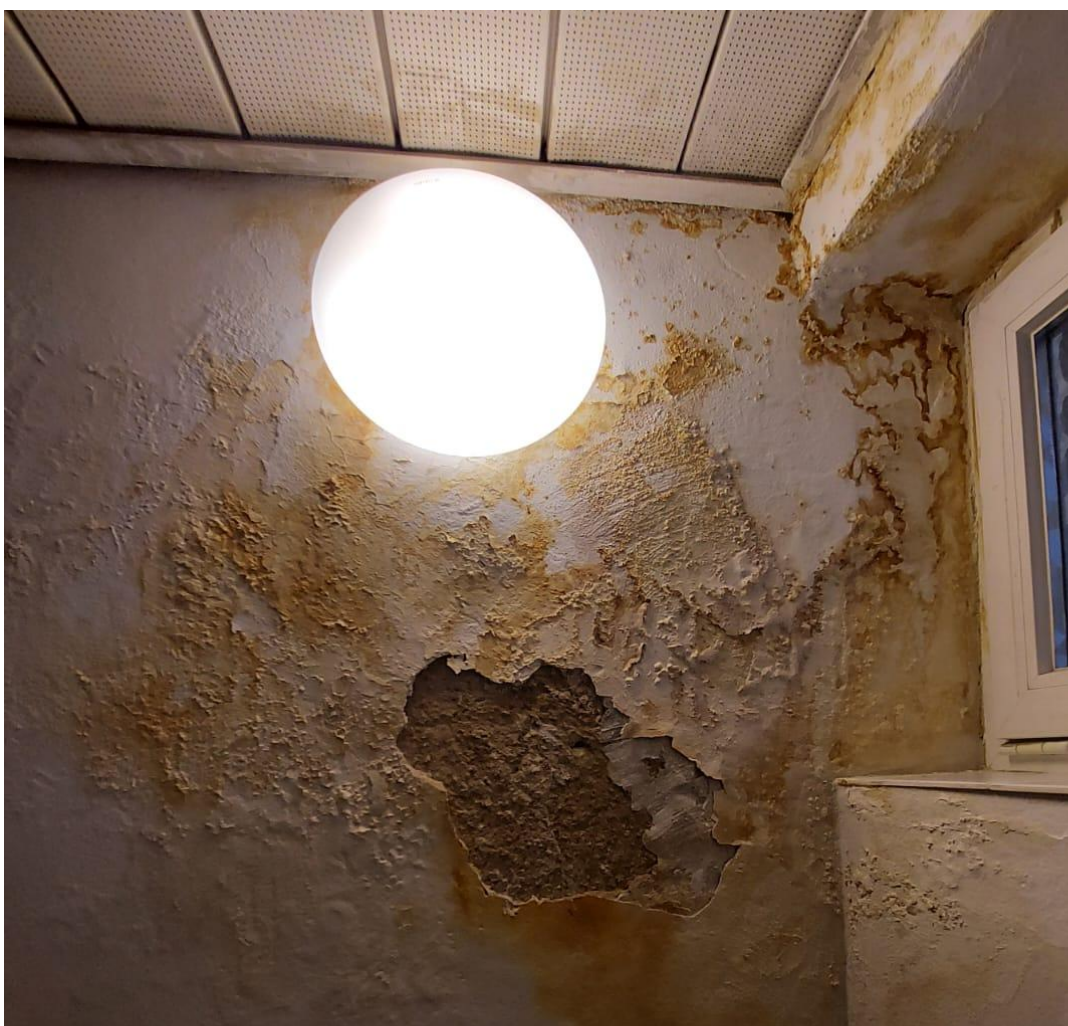
Obrázek č. 2.3 Zatékání střechou
