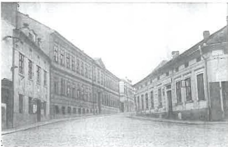
Cca 1920 – budova radnice má modernější „rondokubistickou“ fasádu
